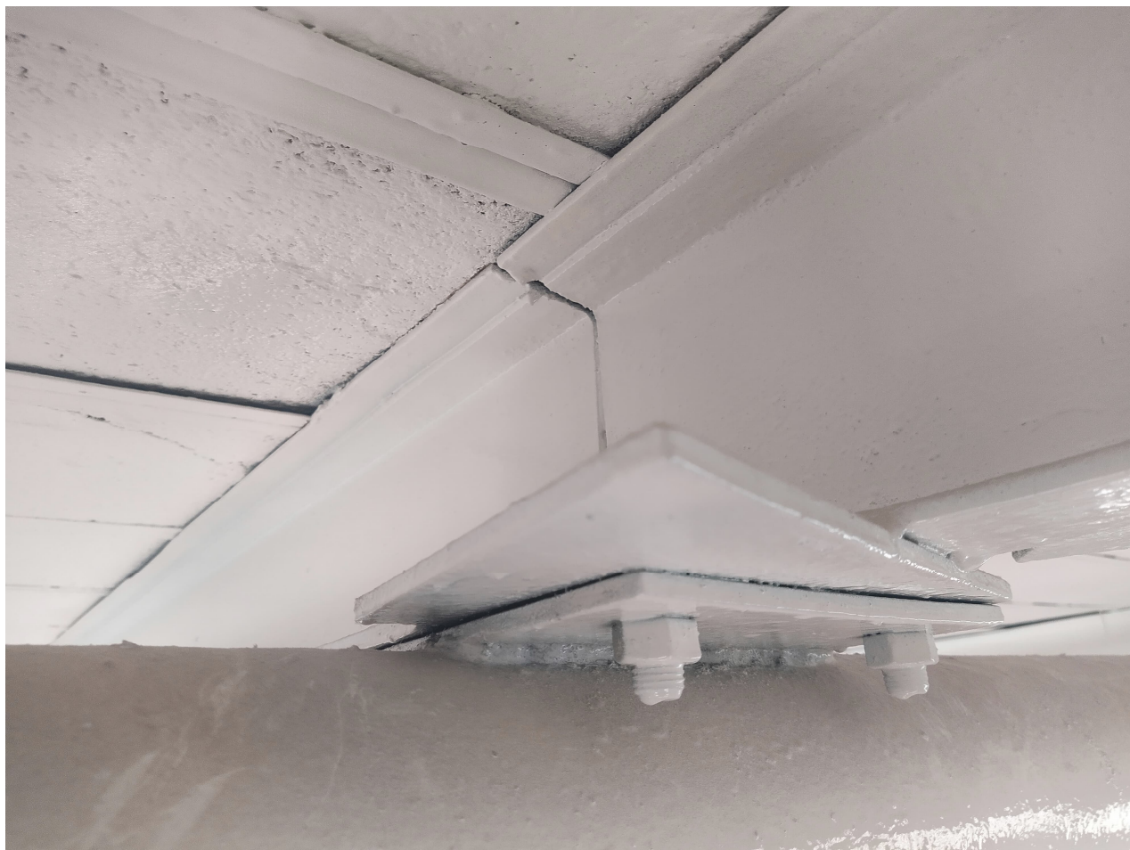
foto č.4 – Detail uložení vaznice na vazník
