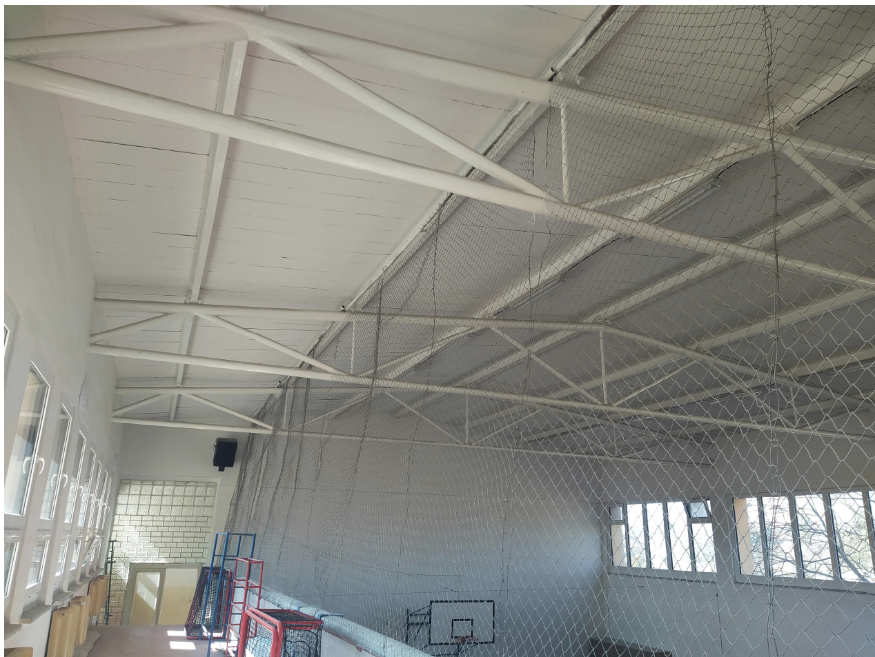
foto č.1 – Nosná konstrukce střechy
