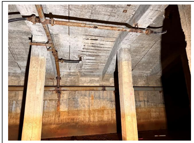
Foto PAS 032 – prostor pod bazénem, záteky, vlhkost, opad krycí vrstvy, koroze výztuže a kovových prvků
