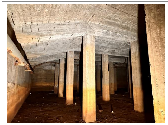
Foto PAS 033 – prostor pod bazénem, záteky, vlhkost, opad krycí vrstvy, koroze výztuže a kovových prvků
