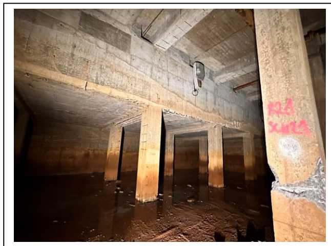
Foto PAS 030 – prostor pod bazénem, záteky, vlhkost, opad krycí vrstvy, koroze výztuže
