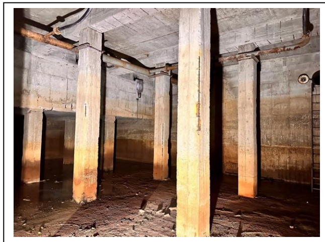
Foto PAS 031 – prostor pod bazénem, záteky, vlhkost, opad krycí vrstvy, koroze výztuže a kovových prvků
