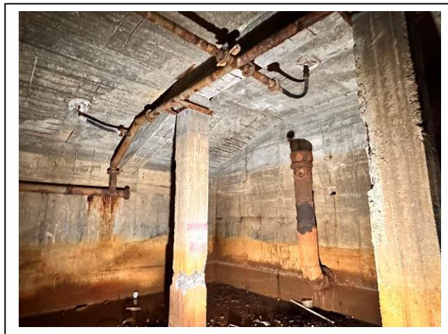
Foto PAS 034 – prostor pod bazénem, záteky, vlhkost, opad krycí vrstvy, koroze výztuže a kovových prvků
