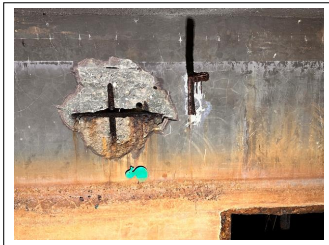
Foto PAS 041 – prostor pod bazénem, záteky, vlhkost, opad krycí vrstvy, koroze výztuže a kovových prvků
