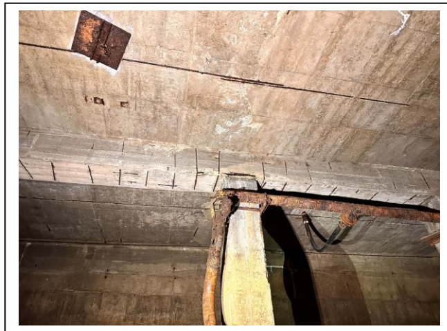
Foto PAS 037 – prostor pod bazénem, záteky, vlhkost, opad krycí vrstvy, koroze výztuže a kovových prvků
