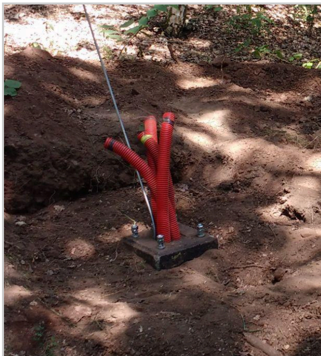
Obrázek X - Příklad pref. ŽB základu pro montáž přírubového stožáru
