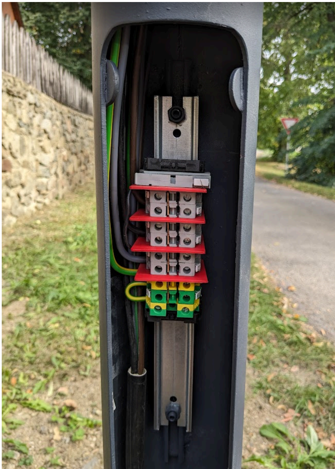
Obrázek X a Y - Správné provedení kabelové rezervy formou smyčky a připojení do svorkovnice, směr od RVO (elektrovýzbroj není referenční typ! viz níže)
