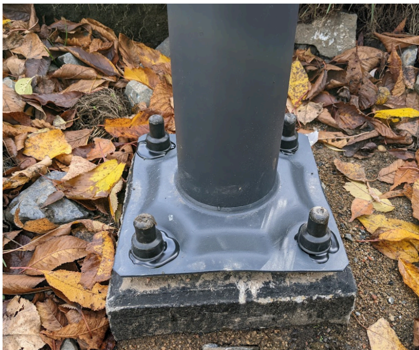
Obrázek X a Y - Ošetření kotvení stožárů k prefabrikované patce proti pronikání vlhkosti zálivkou z bitumenu/asfaltu
