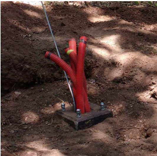
Obrázek X a Y - Prefabrikované stožárové ŽB základy pro přírubový stožár
