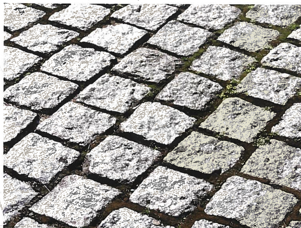
ŽULOVÉ KOSTKY plocha autobusových zálivů, přídlažba vozovky
