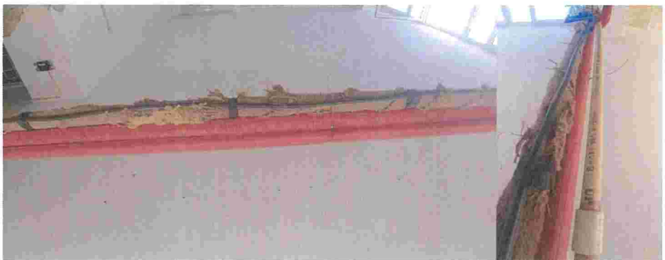
Staré rozvody v učebně dle
