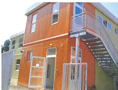
zábradlí tahokov - MŠ Modřice
