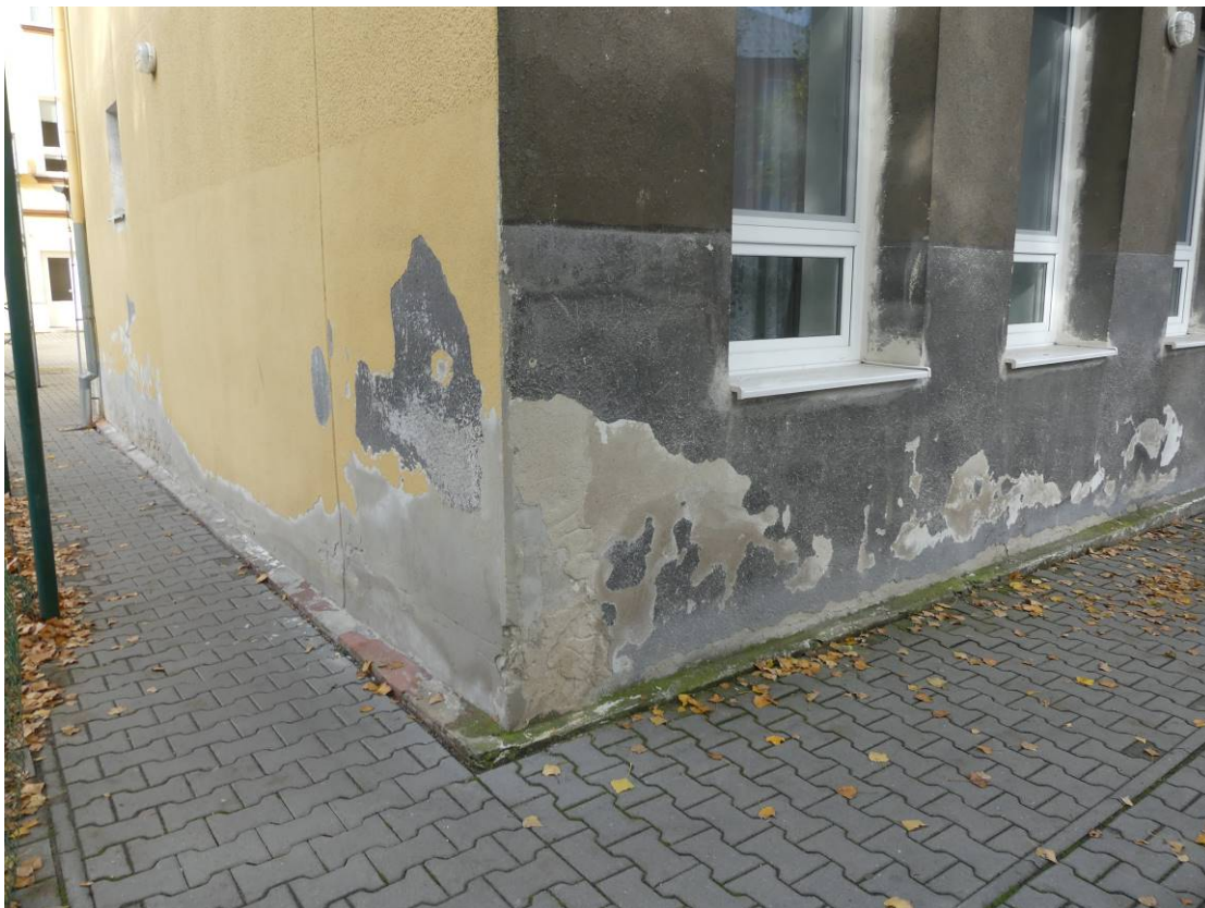
Foto 1 – Pohled na fasádu objektu školní družiny, v tomto rohu objektu v prostorách interiéru byl odebrán vzorek zdiva s označením V2
