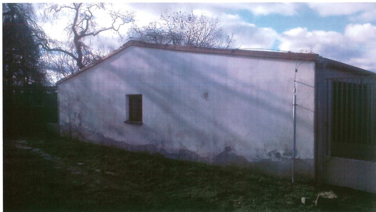
Stěna k opravě
